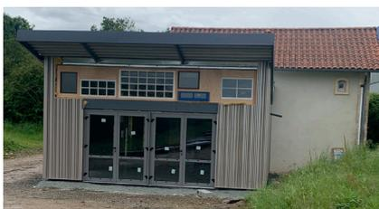
Les travaux de l'atelier solidaire ReCYCLE ont été lancés fin 2023. Les bâtiments se veulent en accord avec le principe d'économie circulaire du projet puisqu'ils sont montés à partir de matériaux de seconde vie issus de chantiers.
